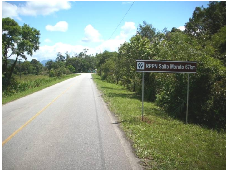
Figura 32 – Placas de sinalização sobre a RNSM antes do entroncamento das PR-430 e PR-405
